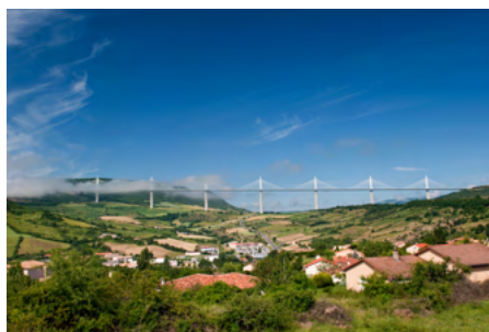
Millau Viaduct, Occitanie, France
